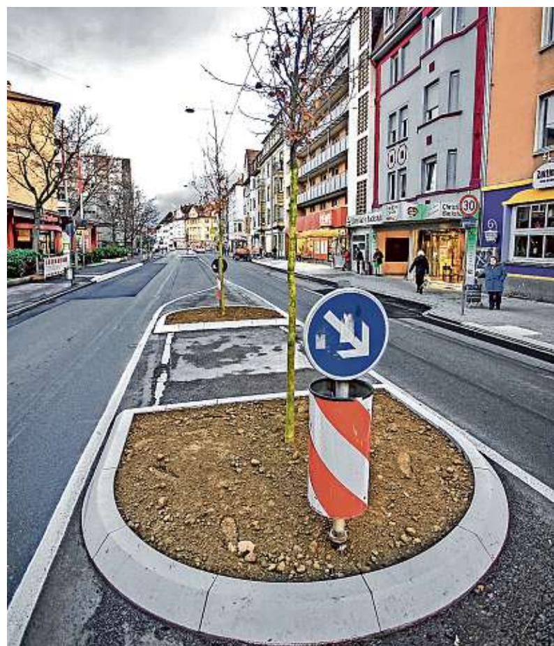
Die beiden Beete mit Eisenholzbäumen machen die verbreiterte Querungshilfe auf der Hohenzollernstraße noch besser sichtbar.
