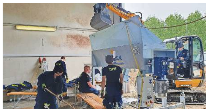
Das THW Pforzheim ist derzeit mit drei Zügen in Ulm, um unter anderem Sandsäcke zu befüllen und anderweitig Hilfe bezüglich des Unwetters zu leisten.
