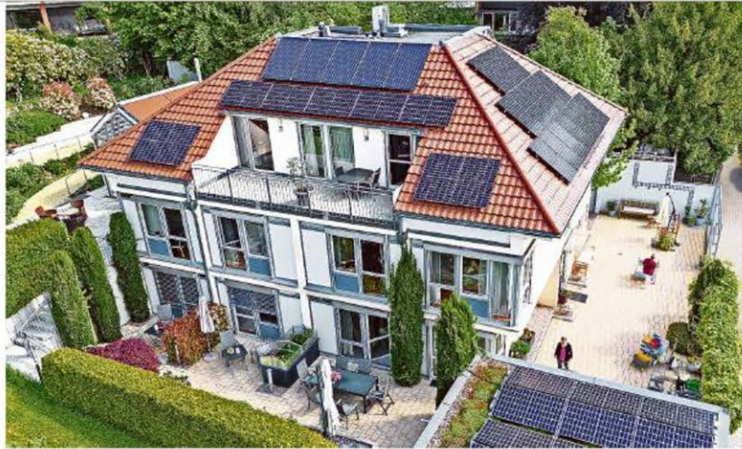
In die Dachlandschaften eingefügt: Die Photovoltaik- und Solarthermiemodule können nun arbeiten. FOTOS: RÖHR
