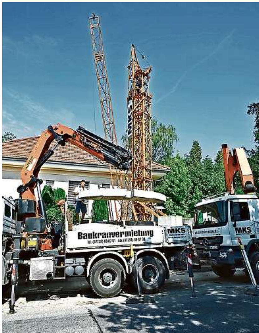
Stück für Stück wird der Kran vor dem Christlichen Hospiz abgebaut – noch in dieser Woche soll die Baumaßnahme komplett abgeschlossen sein. FOTO: MORITZ
