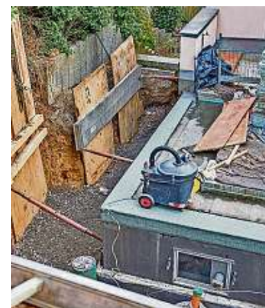
Teils wurden die Schächte schon verfüllt.
