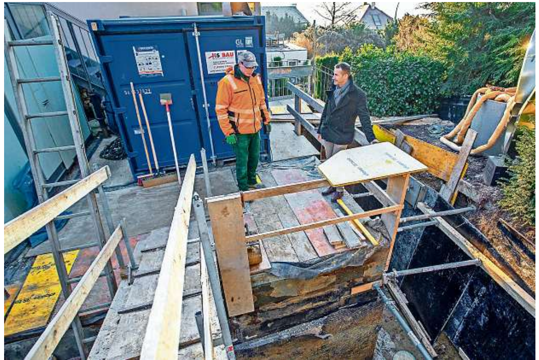
Martin Gengenbach, Geschäftsführer des Christlichen Hospizes (rechts), und Polier Steffen Gommel von HS-Bau gewähren der PZ Einblick in die Baustelle hinter dem Gebäude an der Heinrich-Wieland-Allee.
